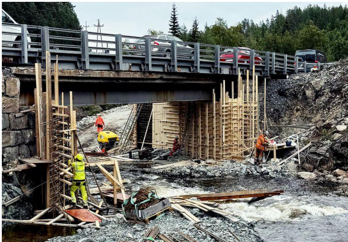
Arbeidet med ny Kobbervoll bru har pågått siden august. Mellom 31. oktober og 3. november skal gammel bru fjernes og ny etableres. Foto: Bjørn Halvor Hegna, Statens vegvesen
